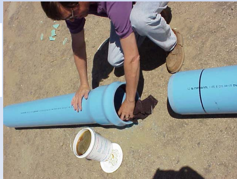
Priprema spoja tvrdih PVC cijevi
